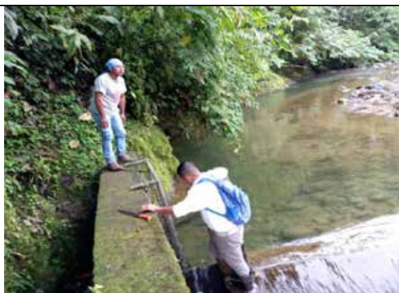
Captación de la vertiente San José de la Junta Administradora de Agua Potable Puenbo
