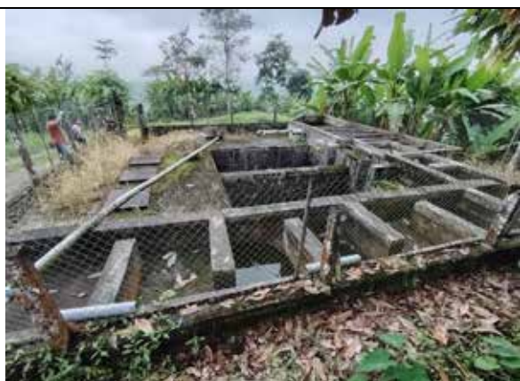
Planta de tratamiento, utilizada como almacenamiento de la Junta Administradora de Agua Potable Puenbo
