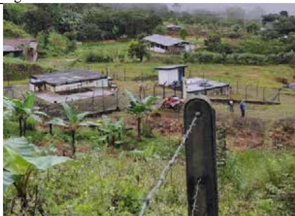
Planta de tratamiento 1 de la Junta Administradora de Agua Potable El Palmar, California y Tilinche
