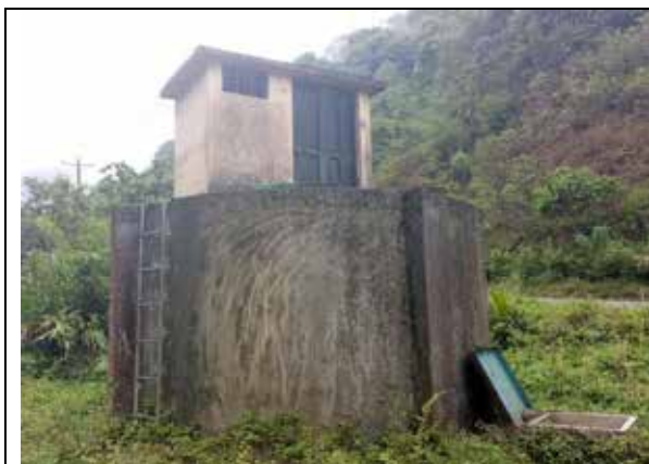
Tanque de almacenamiento de Agua El Negrillo
