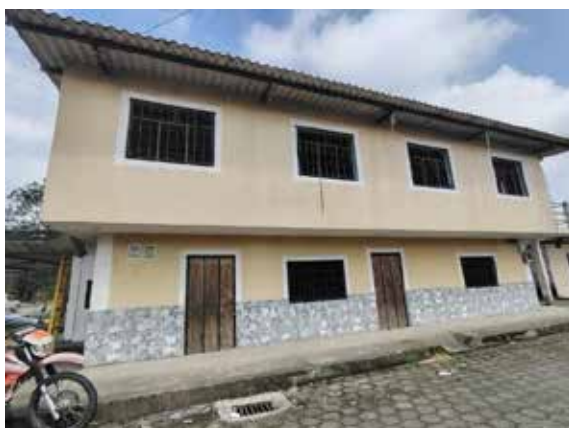
Infraestructura inclusiva (rampas de acceso) CNH Rayito de Luz del Reciento Puembo
