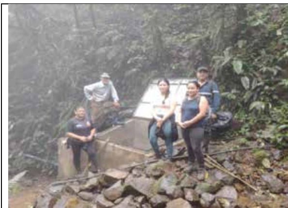
Captación de la vertiente San Antonio de la Palmas de la Junta Administradora de Agua Potable El Palmar, California y Tilinche
