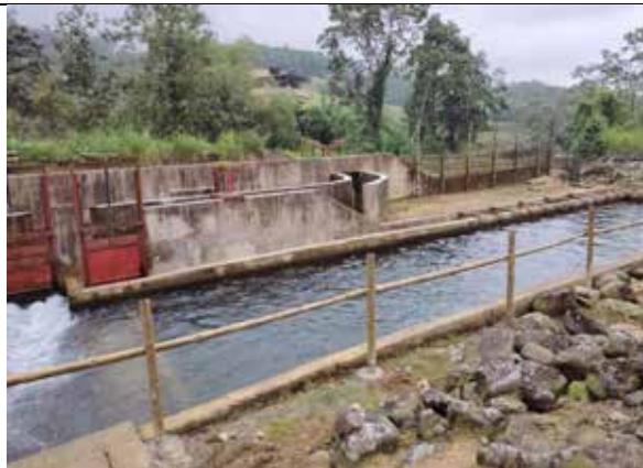
Boca toma Junta Administradora de Agua Potable El Progreso
